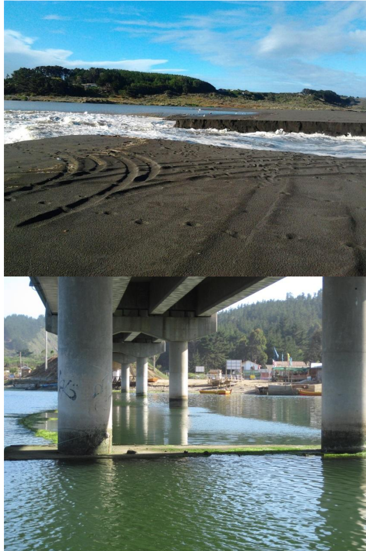
Figura 1. Superior, desembocadura del estero Nilahue. Inferior, pilares del puente de la laguna Cáhuil.
